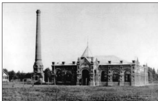
Мытищи. Водозаборная насосная станция водопровода в Москву. 1890 год.
