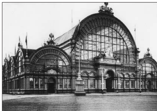
Павильон машинного отдела. Покрытие по проекту В.Г. Шухова
